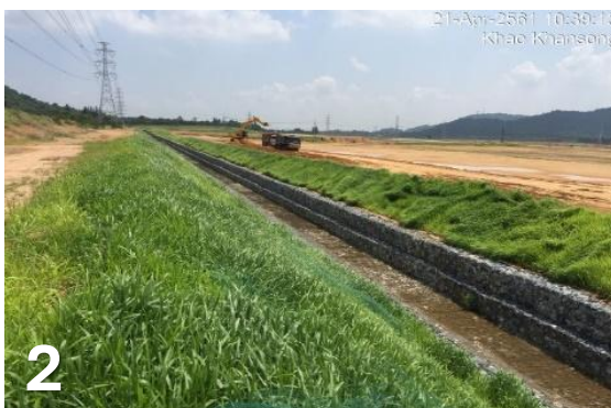
Fig 1-3: รูปภาพคลองระบายน้ำ Gabion
