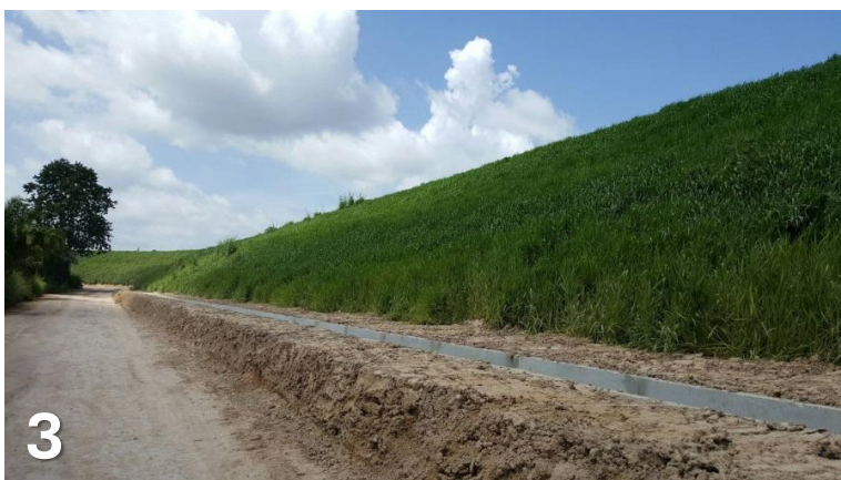
Fig 1-3: ภาพมุมสูงแนว slope ที่ทำการปลูกหญ้ารูซี่
