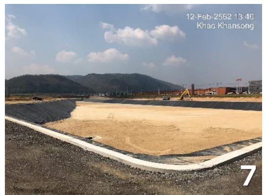
Fig 1-2: รูปภาพออกแบบผสมผสานการใช้ GCL กับ HDPE Fig 2: รูปภาพขั้นตอนการก่อสร้าง Fig 3-7: รูปภาพก่อน/หลังการปู่อ
