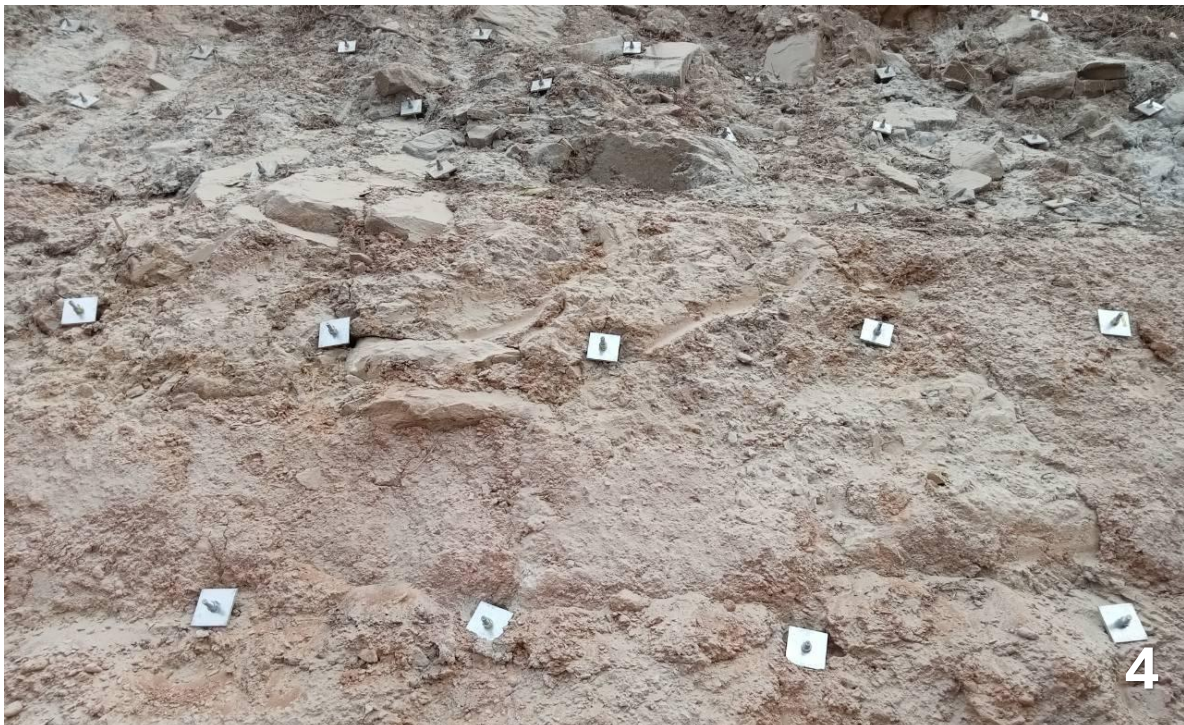
Fig 3: ภาพหมุดยึดดิน (Soil Nail)
