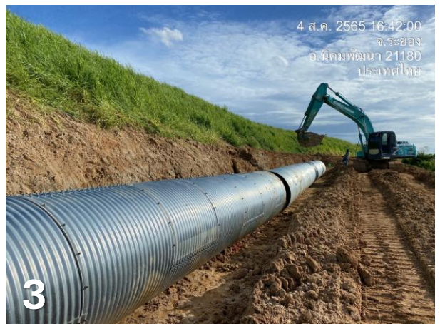
Fig 1-5: รูปภาพขั้นตอนการก่อสร้างท่อระบายน้ำฝนไปยังบ่อ Pond 3
