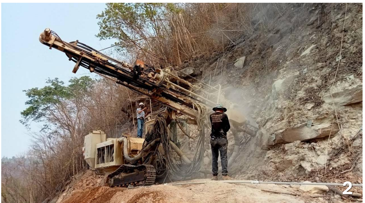
Fig 1: ขั้นตอนการเจาะ Soil Nail บริเวณ Slope ริมถนน
