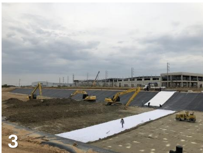
Fig 1-2: รูปภาพออกแบบผสมผสานการใช้ GCL กับ HDPE Fig 2: รูปภาพขั้นตอนการก่อสร้าง Fig 3-7: รูปภาพก่อน/หลังการปู่อ
