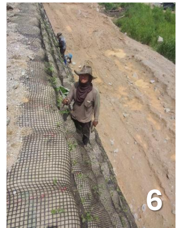
Fig 3-6: รูปภาพการทำกำแพงกันดินโดยใช้กระสอบ + Geogrid ที่แปลง D60 – 62
