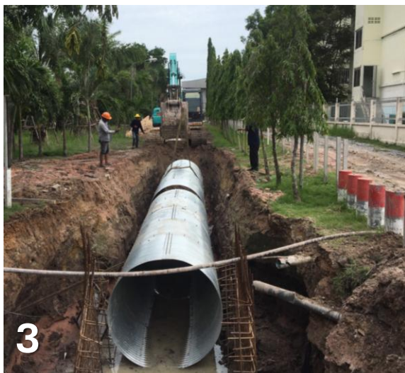
Fig 1-6: ภาพขั้นตอนการติดตั้งท่อลูกฟูก Corrugated Pipe สำหรับงานระบายน้ำ
