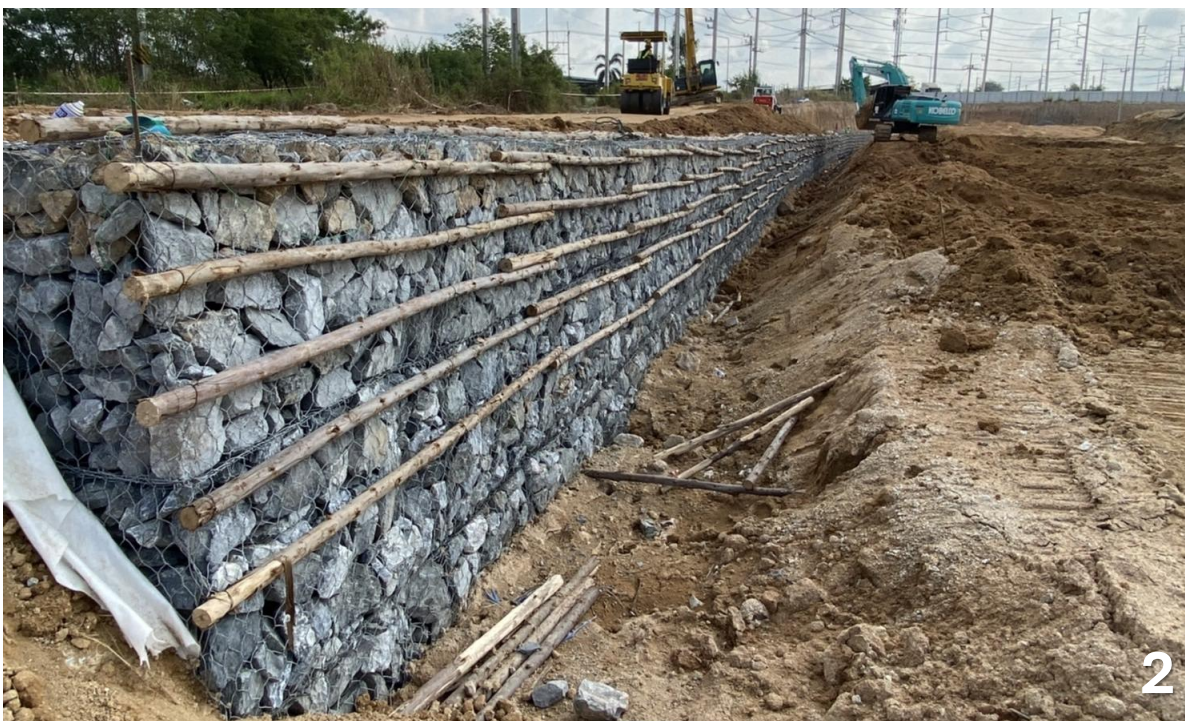
Fig 1-2: ภาพพื้นที่โครงการขณะทำการก่อสร้าง
