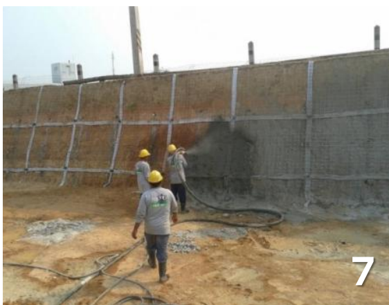
Fig 6: ขั้นตอนดำเนินการทำ Soil Nail
