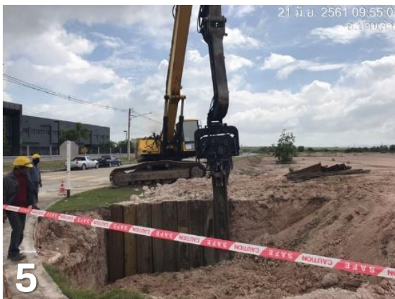
Fig 1-6: รูปภาพขั้นตอนการก่อสร้างท่อระบายน้ำเสีย (HDPE)
