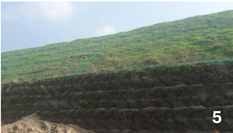
Fig 3-6: รูปภาพการทำกำแพงกันดินโดยใช้กระสอบ + Geogrid ที่แปลง D60 – 62
